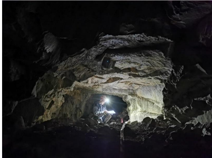
Inspection d'une carrière souterraine en chambres et piliers par un agent du Service Commun des Carrières Souterraines (photo SCCS)
