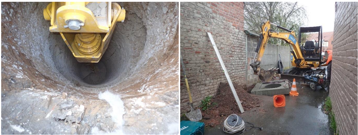
Creusement et aménagement de nouveaux puits d'accès pour permettre l'inspection de carrières souterraines inaccessibles (photos SCCS)
