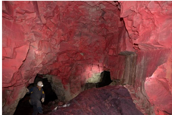
Zone de carrière dégradée ayant été peinte (photo SCCS)
