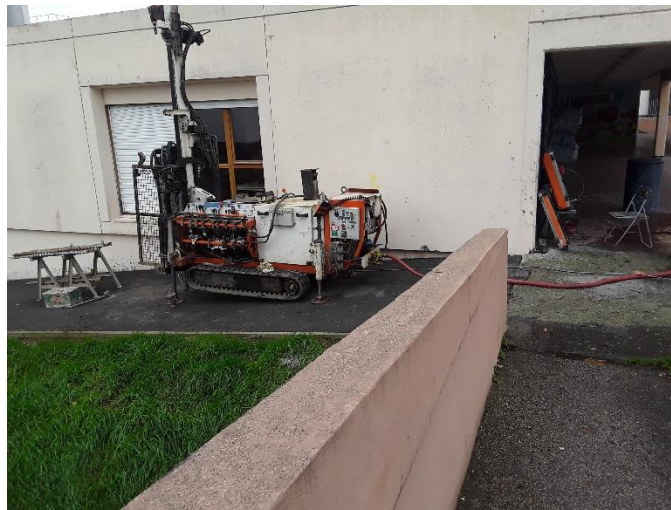
Sondage géotechnique pour la recherche de vides (photo SDICS)
