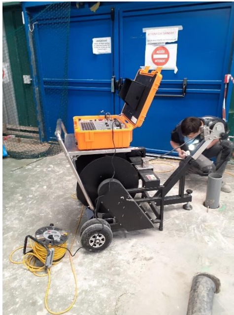
Inspection caméra d'un forage ayant rencontré du vide (photo SCCS)
